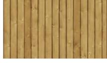
VERTICAL WOOD SIDING: 6" PINE VERT SIDING W/ MITERED CORNERS FINISH: STAINED; TYPICAL
